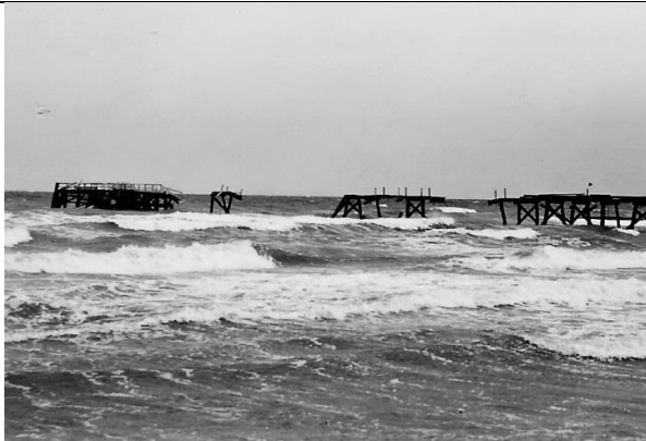
Bild 1: ca 1942 Die Dahmer Seebrücke wurde 1911 von privater Hand erbaut. Sie erlaubte den Dampfschiffsverkehr ohne das „Ausbooten“. Die Brücke wurde zweimal (1922 und 1941) durch Sturm und schweren Eisgang zerstört.
